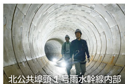
北公共埠頭1号雨水幹線内部
