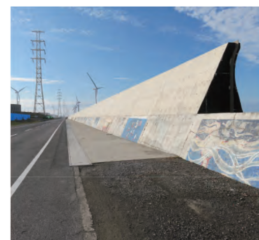
▲日川海岸高潮対策の様子
