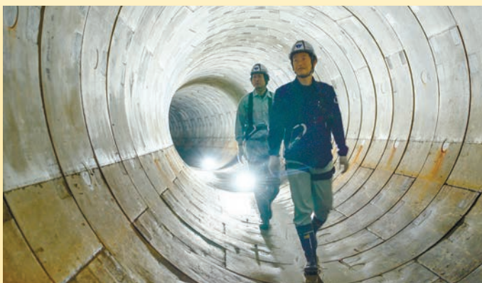
北公共埠頭 1 号雨水幹線内部
